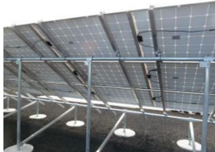
1A. Solar Array Racking & 4. Wiring
